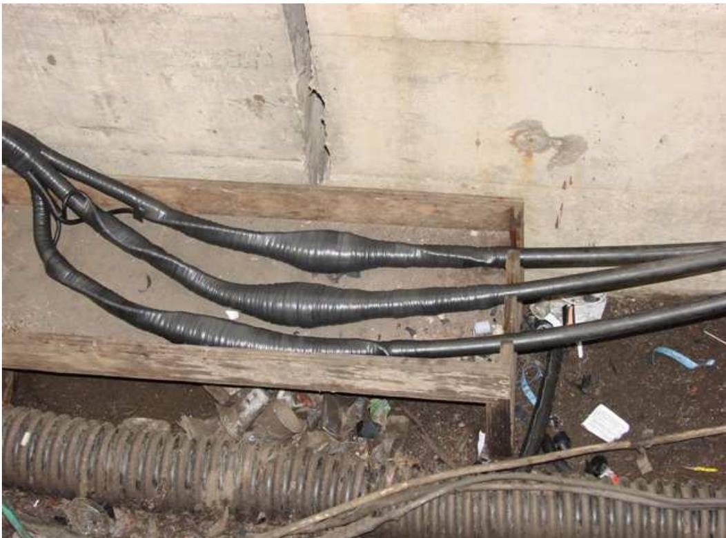
Emenda do cabo elétrico PT02 na caixa após o corte de 100 metros de cabo (acidente)
