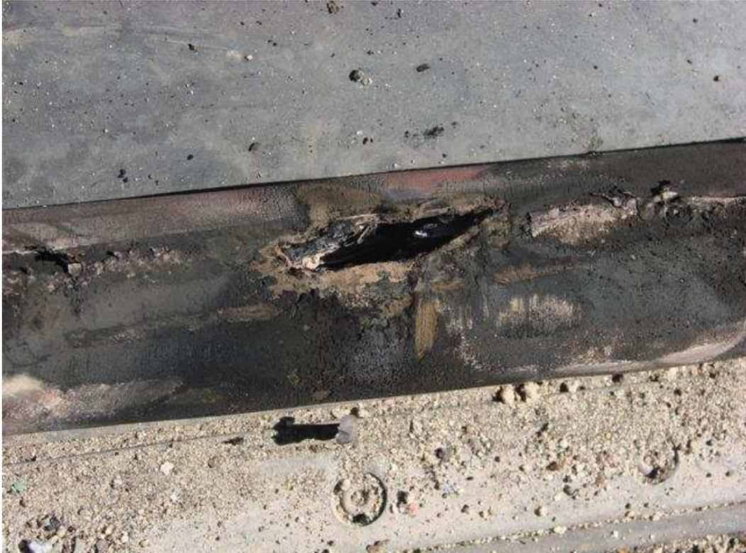
Cabo alimentação do PT02 danificado após curto provocado pelo patolamento do GR04
