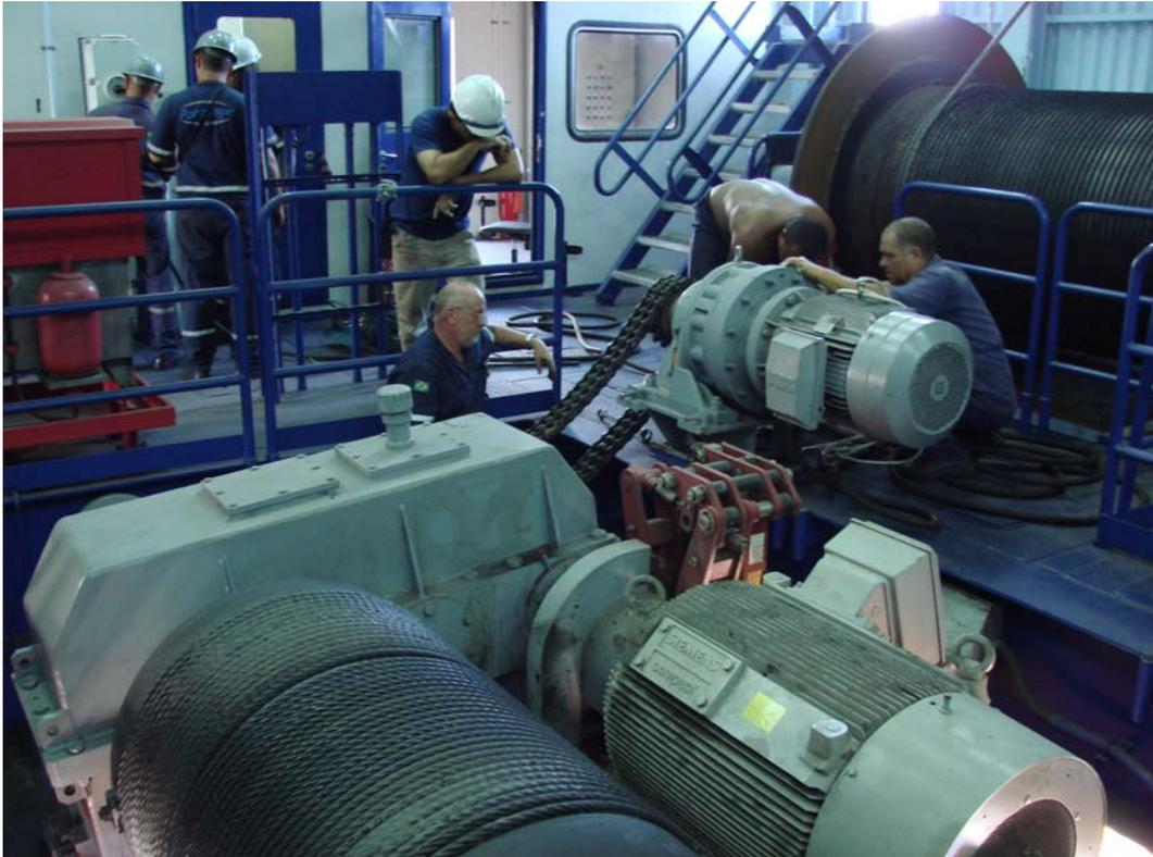
PT-02 – Montagem do motor reserva para emergências no sistema de translação do carro
