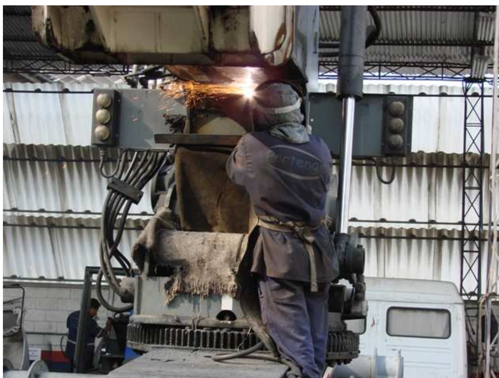
EC-20 - Solda para eliminação de trincas na lança
